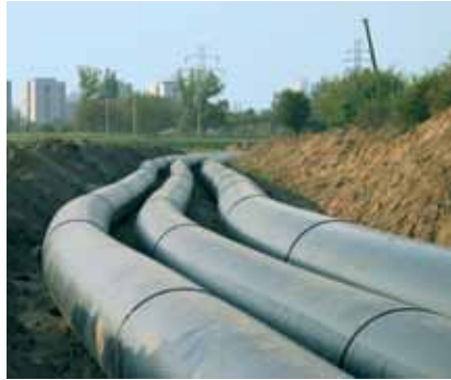
Варшава Перекачивающие коллекторы для очистных сооружений Трубы WehoPipe dn1000 и dn1400 мм
