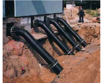
Ополе Расширение очистных сооружений Трубы WehoPipe dn160-900 мм
