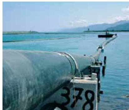
Каели, Турция Морской выпуск в Черное море Трубы WehoPipe dn315-630 мм
