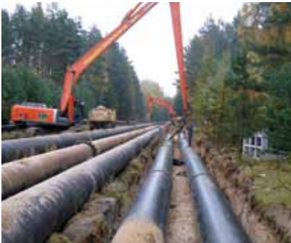
KGHM Польша Медж АС. Технологические трубопроводы Трубы WehoPipe dn710-1200 мм
