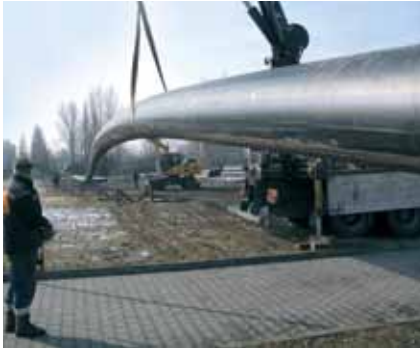
Лодзь Магистральный водопровод Трубы WehoPipe da 800 мм
