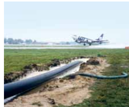
Варшава Водоотведение в аэропорту Окенче Трубы WehoPipe dn355 i dn450 мм
