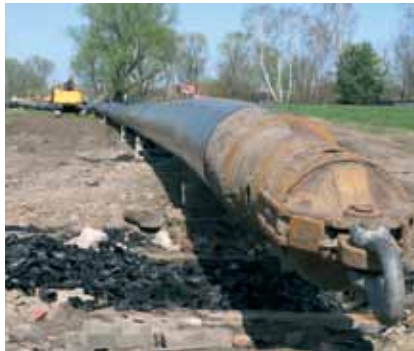
Щечин Горизонтально – направленное бурение Трубы WehoPipe dz1033,2 мм
