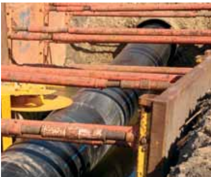
Вроцлав Восстановление методом релайнинга Трубы WehoPipe d.1030 мм
