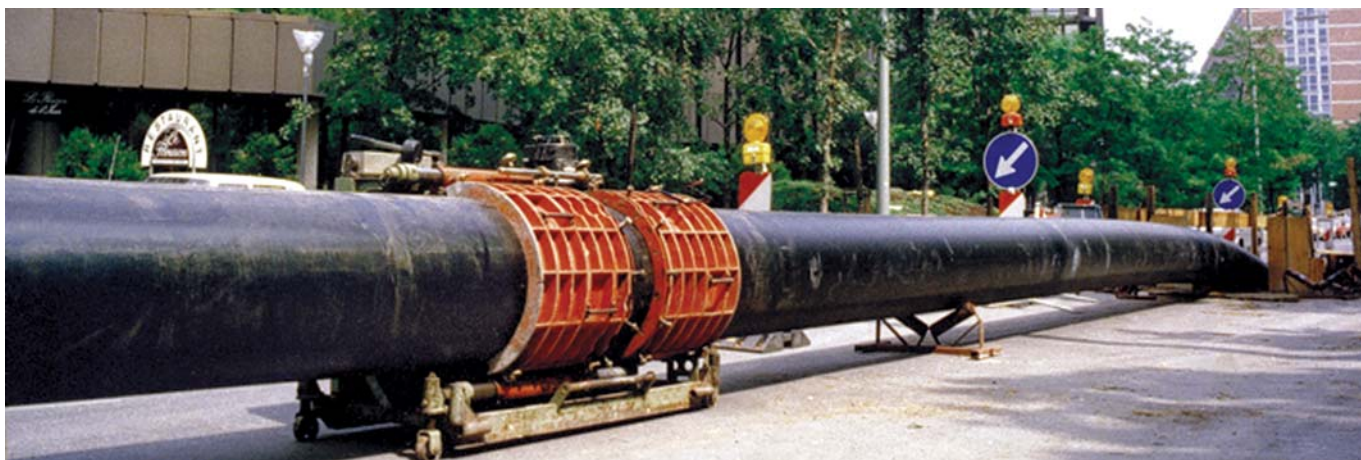
Реконструкция трубопровода с использованием полиэтиленовой трубы диаметром 630 мм.
