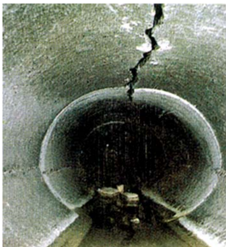
Старая труба, нуждающаяся в реновации.
