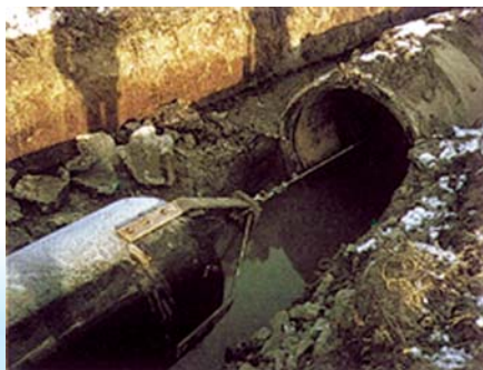
Реконструкция трубопровода с использованием полиэтиленовой трубы диаметром 630 мм.
