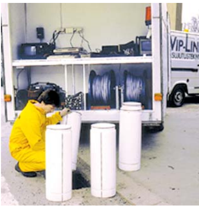
Установка модулей "ВипЛайнер" производится через инспекционные колодцы.
