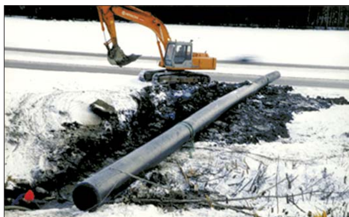
Реновация дренажной системы с помощью трубы СПИРО.
