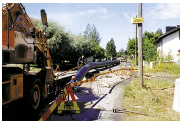
Предварительно соединенные сваркой трубы СПИРО вводятся в старый бетонный канализационный коллектор при помощи экскаватора.
